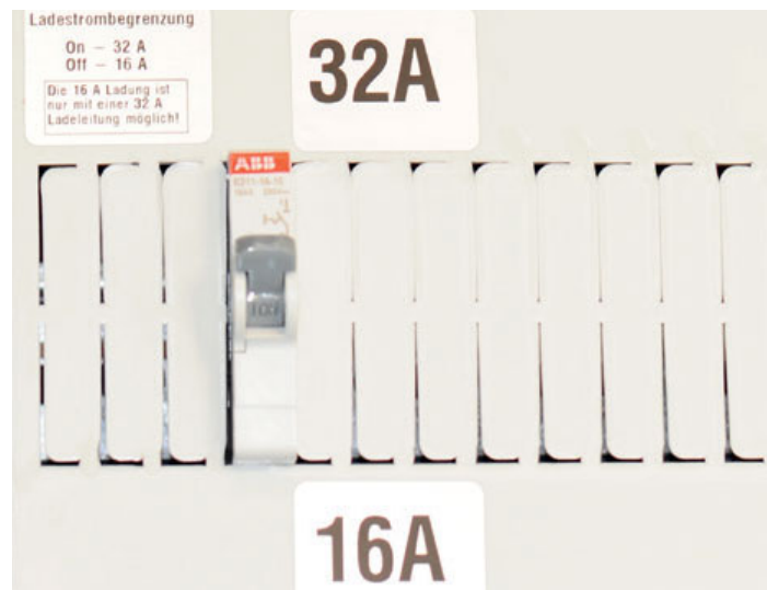
Автоматическое переключение между 22 кВ/ 32 А и 11 кВ/ 16 А
